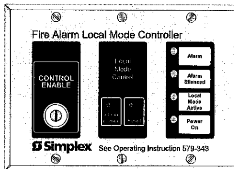
Local Mode Controller Module
